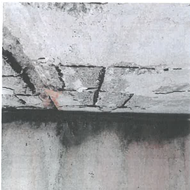
Tilto perdangos plokščių deformacijos
