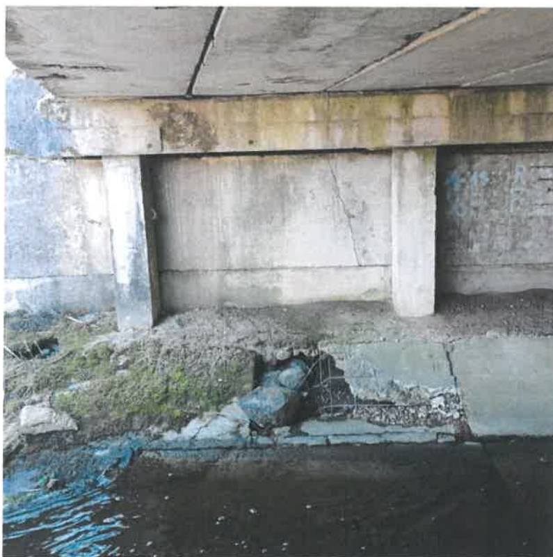
Tvirtinimų deformacijos
