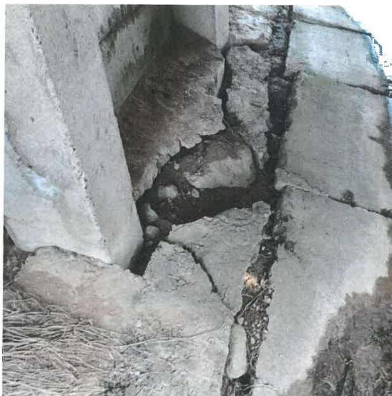
Tvirtinimų deformacijos
