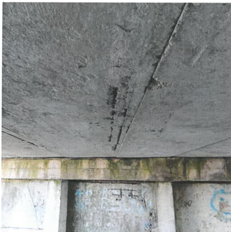
Tilto perdangos plokščių deformacijos
